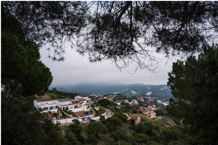
Urbanización Vistamar, en Sant Cebrià de Vallalta, con deficiencias urbanísticas: terrenos sin asfaltar o mal asfaltados, problemas de alumbrado público, desprendimientos y falta de una red de alcantarillado. / MARC ASENSIO CLUPES / EPC
