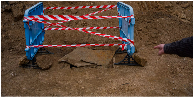
Urbanización Castellar d'Índies, en Sant Cebrià de Vallalta, con deficiencias urbanísticas: terrenos sin asfaltar o mal asfaltados, problemas de alumbrado público, desprendimientos y falta de una red de alcantarillado. / MARC ASENSIO CLUPES / EPC
